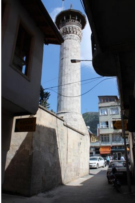
Şekil 1: Sarımiye Camii Minaresi
