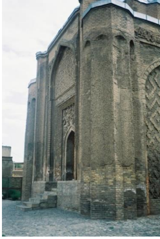
Foto.15- Dış Cephe Köşe Kulecikleri
