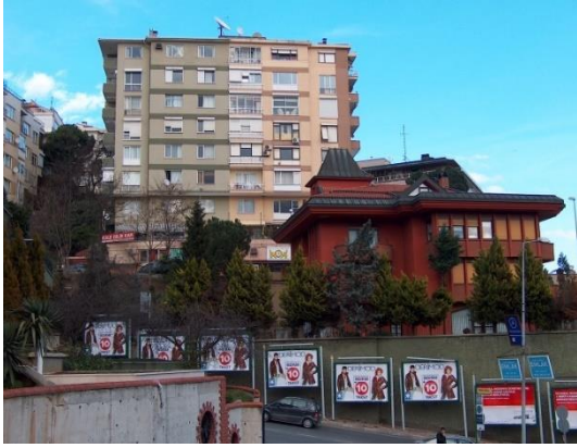
Şekil 22: Bebek'te tarihi dokuyu bozan çok katlı apartman yapıları
