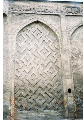
Foto.22- Batı Cephe Tuğla
